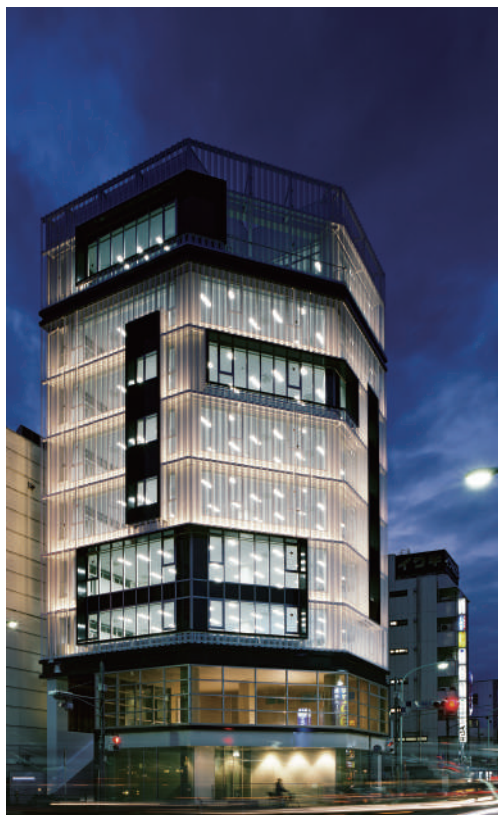
(東京都武蔵野市／商業施設)
